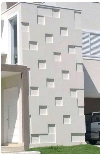
**3D externo fabricado com concreto celular. Peças mais leves e perfeito acabamento.**
