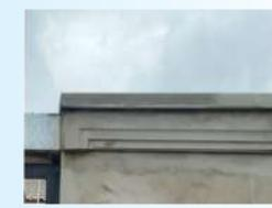
Retirar o excesso de argamassa entre as molduras em até 3 horas. Após este período, usar lixa de ferro com grama de 30 ou 60 para não danificar o acabamento.
